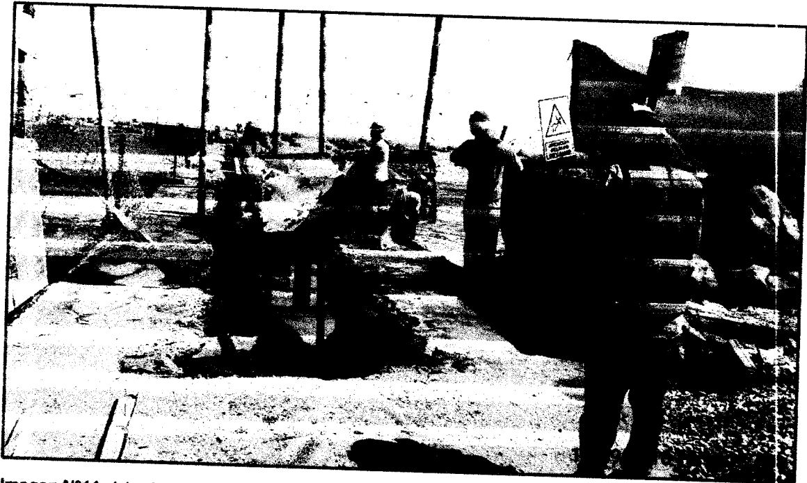
Imagen N°11: A la vista de la imagen se aprecia a los trabajadores cercando la entrada al muelle Acapulco para evitar accidentes de los pobladores.
